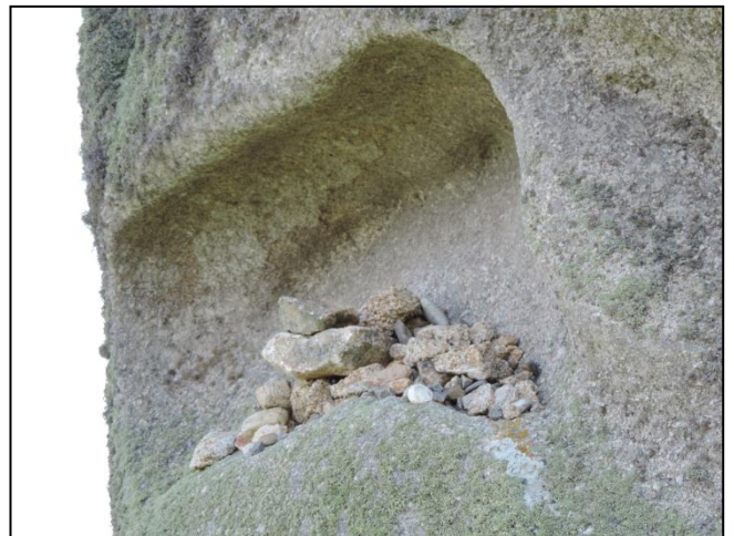
Cuvette d'érosion présente à 3 m de hauteur sur la face nord.
