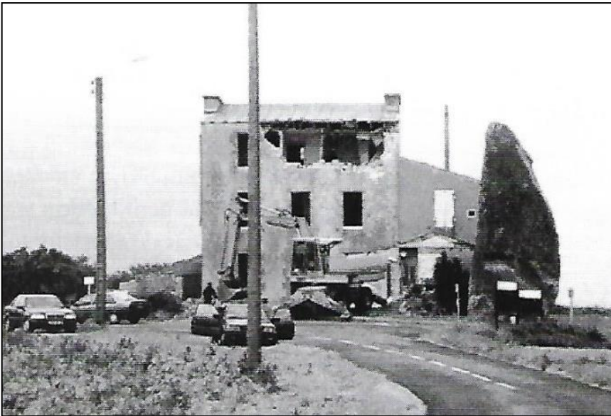
La municipalité de Brignogan-Plages a acquis la maison qui jouxtait le menhir en 1996 et l'a été détruite. Pendant la démolition de la maison et avant l'installation de la nouvelle croix (LE GOFFIC 1999).
