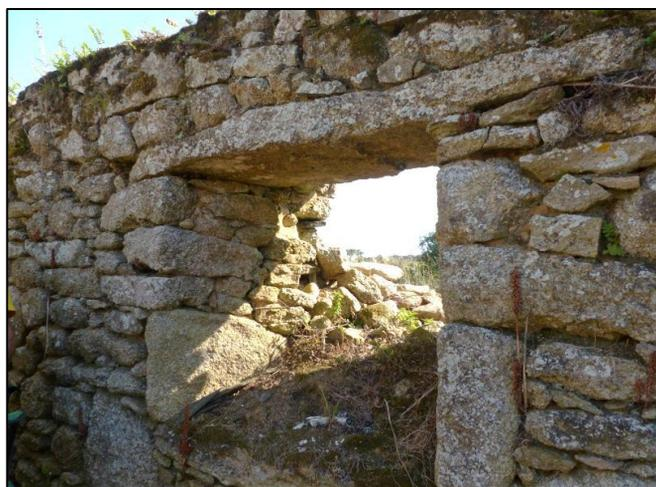
Fig. 10 - Vue intérieure de la fenêtre de l'étable A. Montants et linteau en gros éléments granitiques bien façonnés. Linteau monolithique formé d'une grande dalle granitique. Murs en moellons. A l'extérieur : dépôt provisoire de pierres écroulées.
