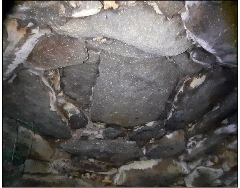
Fig. 47 - Vue du plafond en encorbellement de dalles de microgranite.
