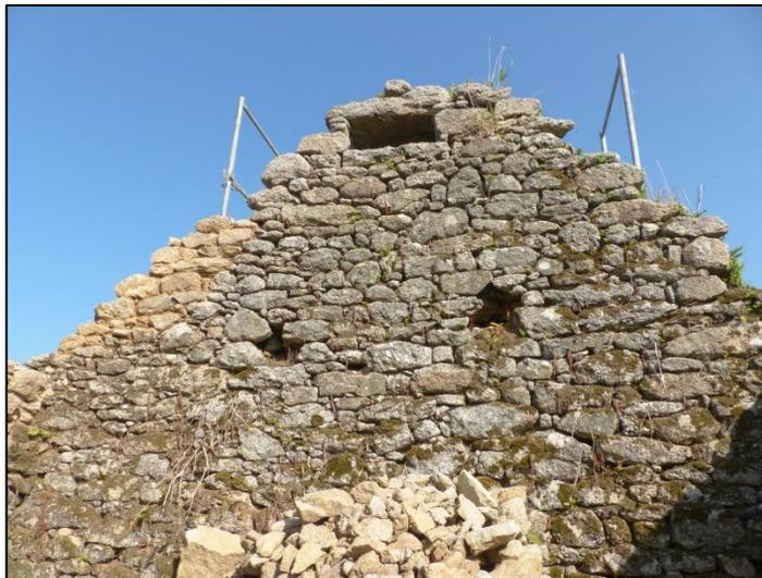
*Fig. 6 – Pignon face est, entre l'étable A et l'écurie B, en moellons granitiques hétéromorphes. En bas, pierres en attente pour la restauration en cours.*
