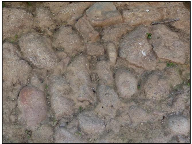
*Fig. 12 – Dallage au sol en grande partie en galets (au centre de l’étable A).*
