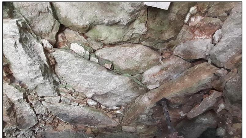
Fig. 29 : Le plafond en encorbellement. Le plafond du toull al ludu devait résister à la chaleur des braises et était donc construit en dalles de pierre posées en encorbellement, c'est-à-dire se chevauchant progressivement pour créer une voûte.
