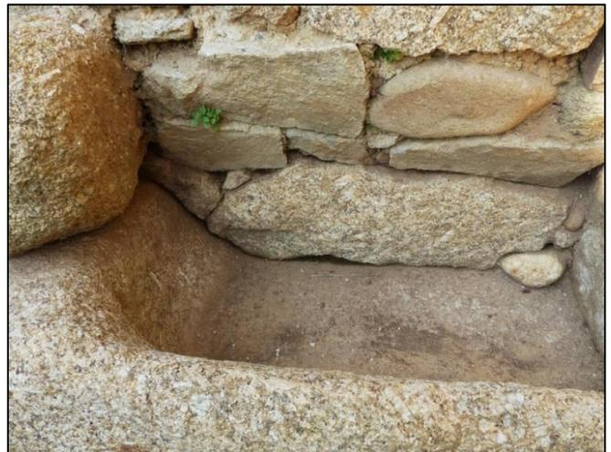
*Fig. 15 et 16 - Dans le mur nord de l’étable B, une auge en granite porphyroïde de Brignogan, longueur : 95 cm ; largeur : au moins 40 cm ; hauteur : 45 cm ; épaisseur : 17 cm, encastrée dans le mur avec moellons en microgranite à grain fin.*
