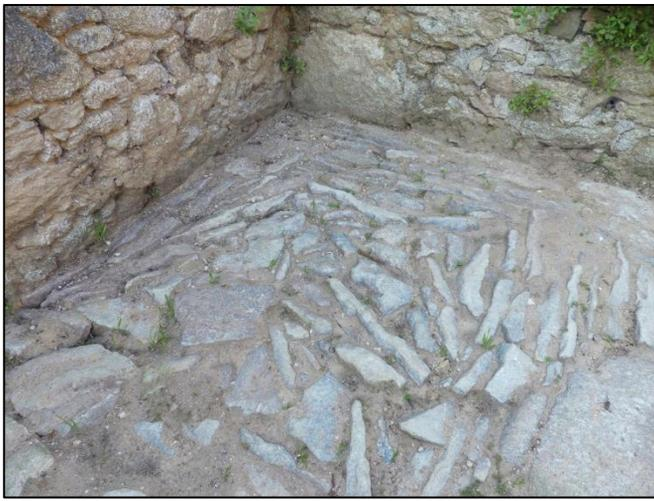
*Fig. 11 – Le sol est formé d’éléments fréquemment très inclinés (partie ouest de l’étable A). Murs en moellons très hétéromorphes.*
